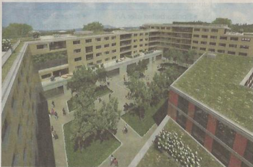
Eine Fussgänger Verbindung zwischen dem Bahnhof und Watt führt durch die Überbauung.
